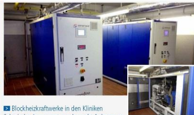
Blockheizkraftwerke in den Kliniken Schmieder. Insgesamt werden acht Anlagen an allen sechs Standorten der Kliniken Schmieder zur Strom- und Wärmeerzeugung eingesetzt; Blick in die Räume der Anlagen und in das Innenleben eines BHKWs.
